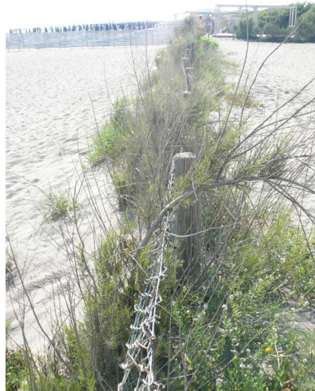
Foto 3 Barriera metallica in maglia sciolta ancorata a pali di castagno e siepe viva di tamerice
